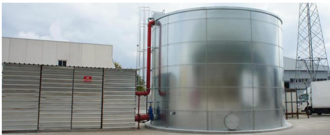
Figura 29. Sistema de abastecimiento de agua contra incendios. Fuente: www.sermamcoin.com
