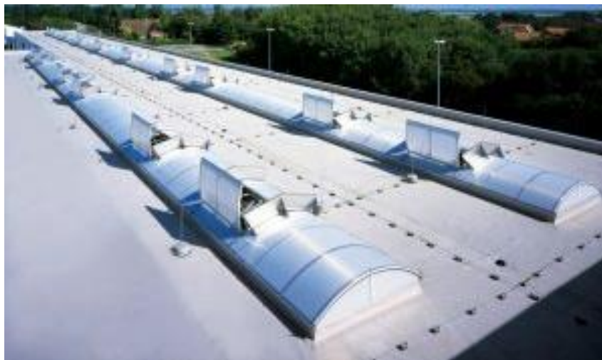
Figura 30. Sistema de extracción de humos. Fuente: www.protech-pci.com
