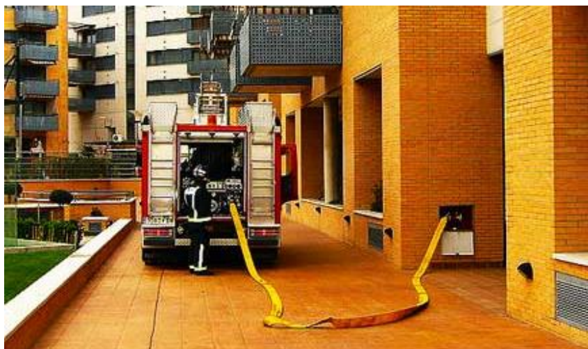
Figura 292. Columna seca. Fuente: www.extintoresnumancia.com
